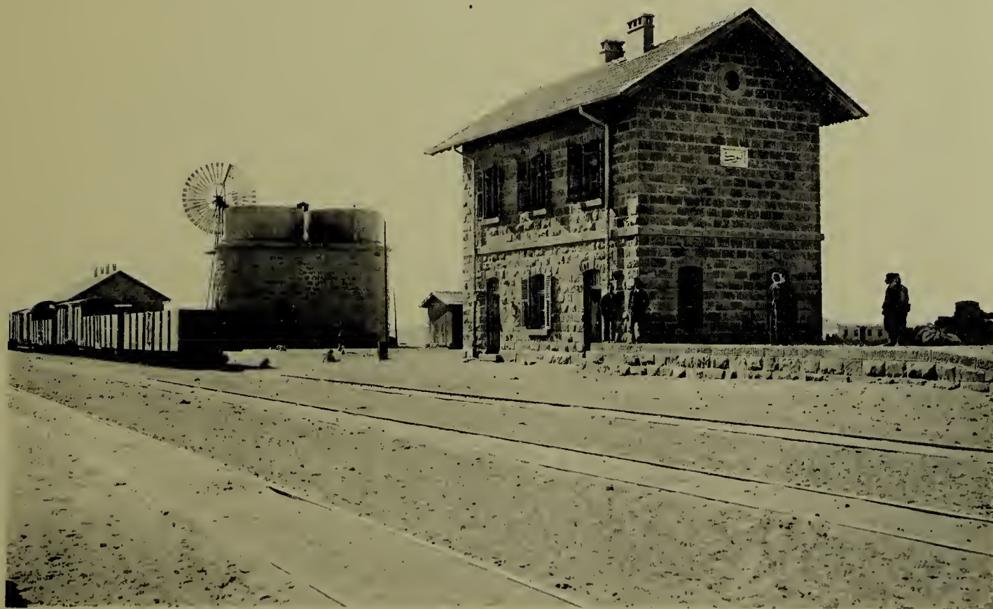
3. — La station de Tebouk.
