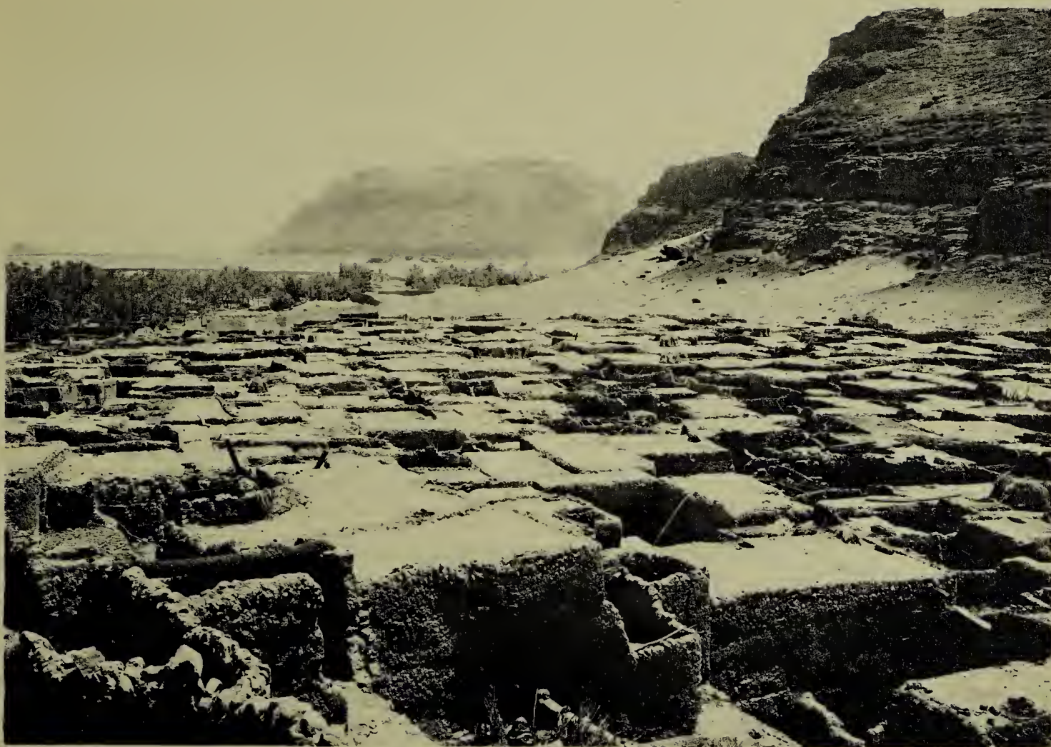
1. — EL-'ELA. Les terrasses des maisons vues du haut du rocher voisin de la citadelle.
