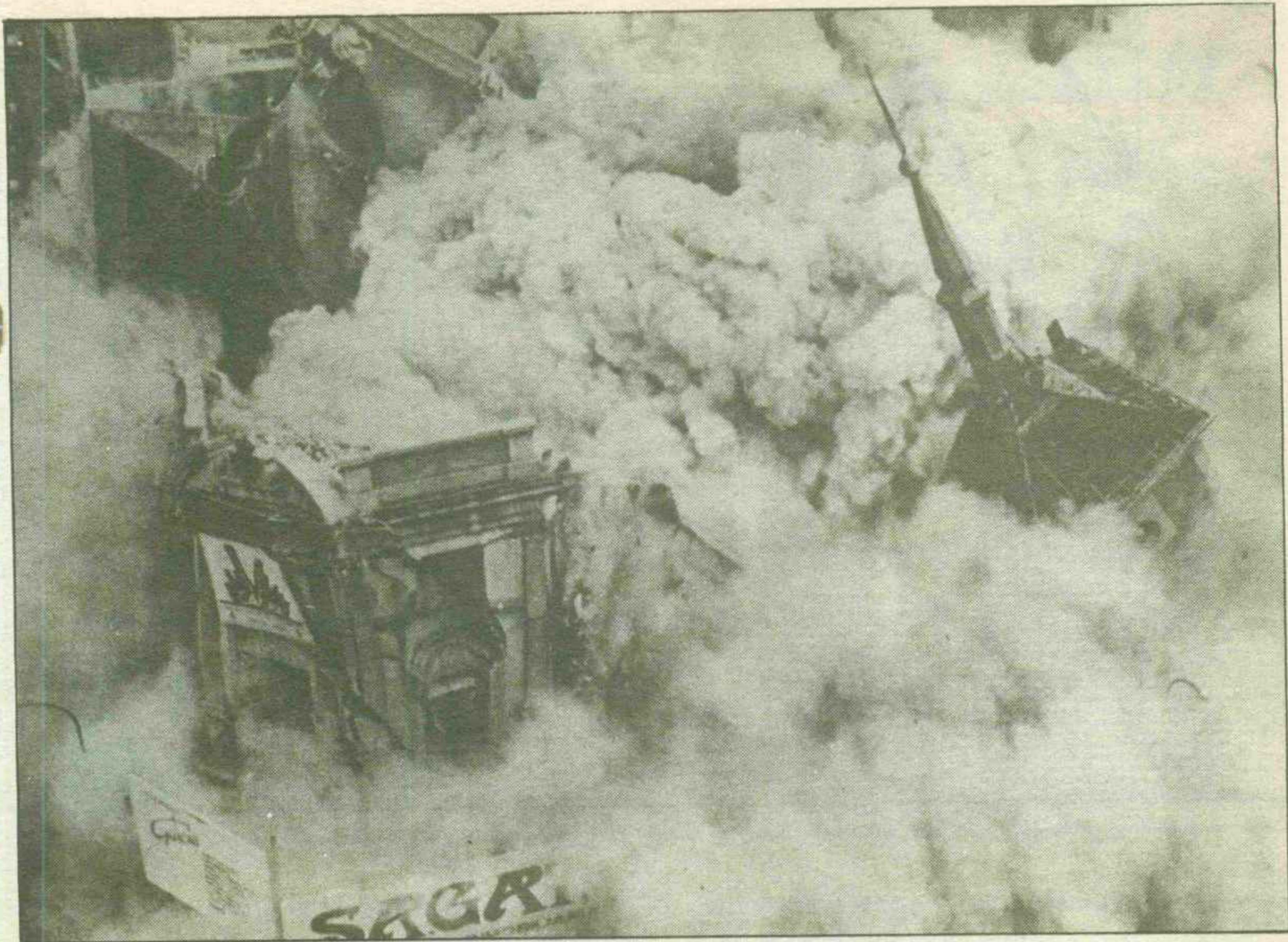
Impresionante fotografía de la voladura del edificio del diario «Madrid».
